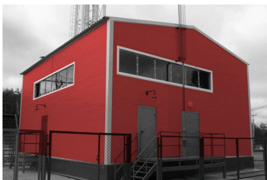
Котлы и котельные
